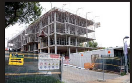
Font: CCMA. Primer edifici en construcció. Octubre 2018
